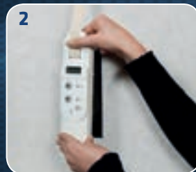
2 Elektrischen Gurtantrieb montieren
