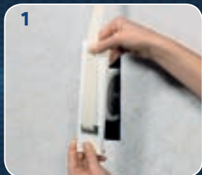
1 Mechanischen Wickler entfernen
